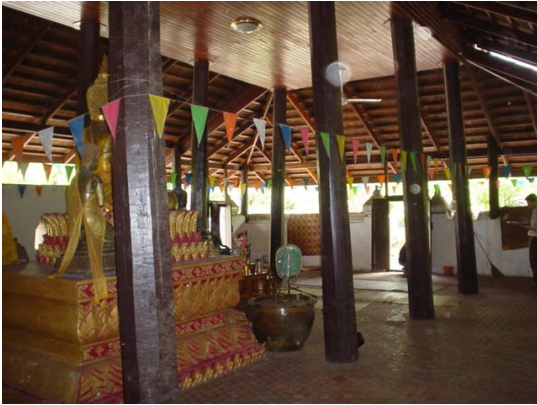
ภาพที่ 9.5 โครงสร้างเสาและโครงสร้างหลังคาของอุโบสถวัดขุนก้อง
