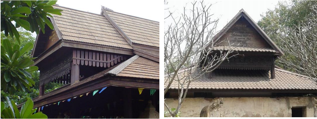
ภาพที่ 9.7 หลังคามุขประเจิดของอุโบสถวัดขุนก้อง ถ่ายเมื่อปี พ.ศ. 2548 วัสดุมุงด้วยแผ่นไม้ (ภาพด้านซ้าย) และถ่ายเมื่อปี พ.ศ. 2558 วัสดุมุงแผ่นเหล็กกรีดลอน (ภาพด้านขวา)
