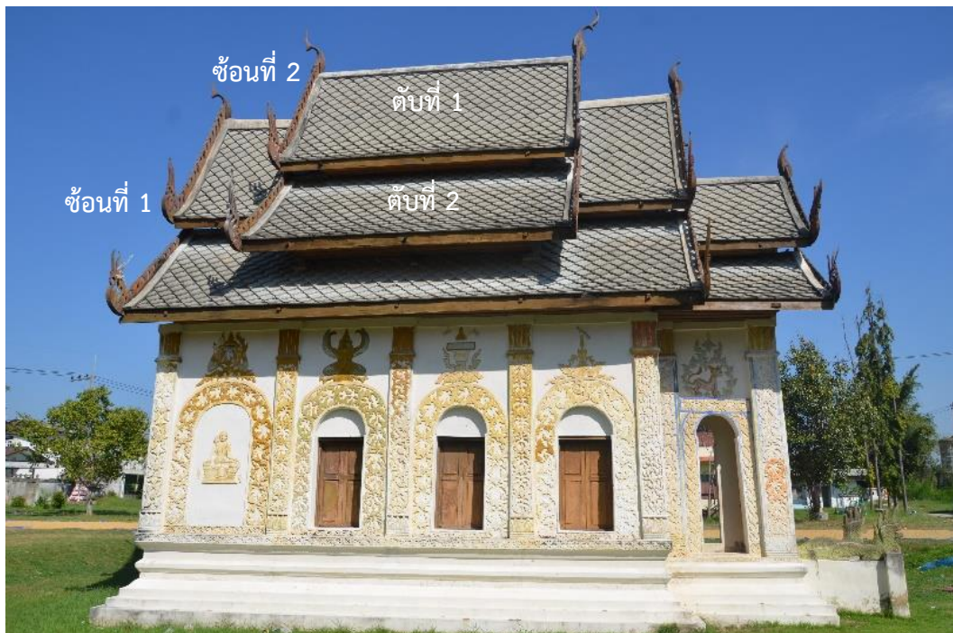
ภาพที่ 7.6 หลังคา และซุ้มหน้าต่าง อุโบสถวัดหนองบัวเจ้าป่า
