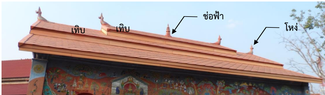
ภาพที่ 6.7 ส่วนประดับหลังคา อุโบสถวัดมณีจันทร์
