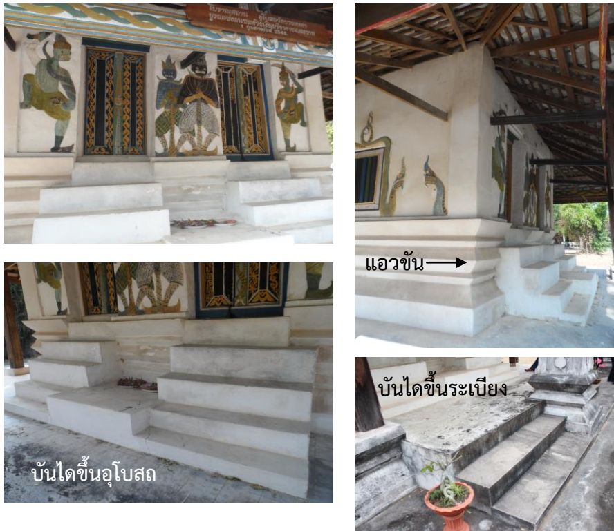
ภาพที่ 5.8 บันไดและฐานแอวขันของอุโบสถวัดบรมคงคา
