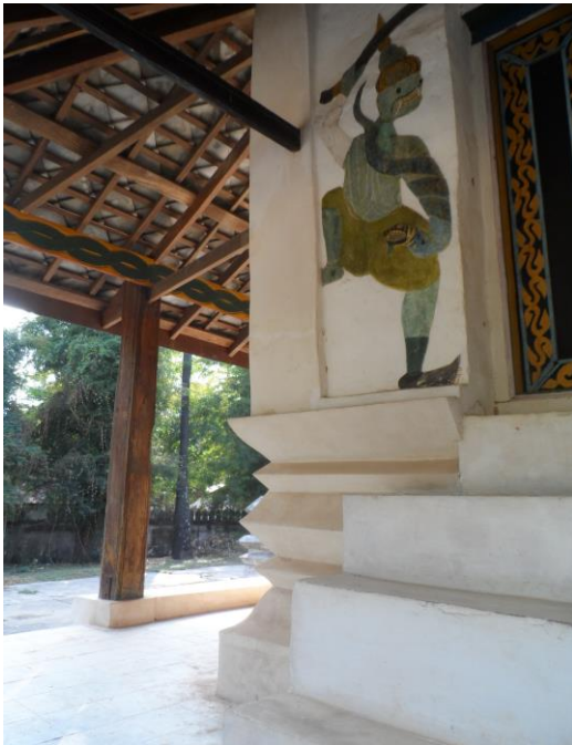
ภาพที่ 5.4 โครงสร้างเสาและโครงหลังคาของระเบียงรอบอุโบสถวัดบรมคณา
