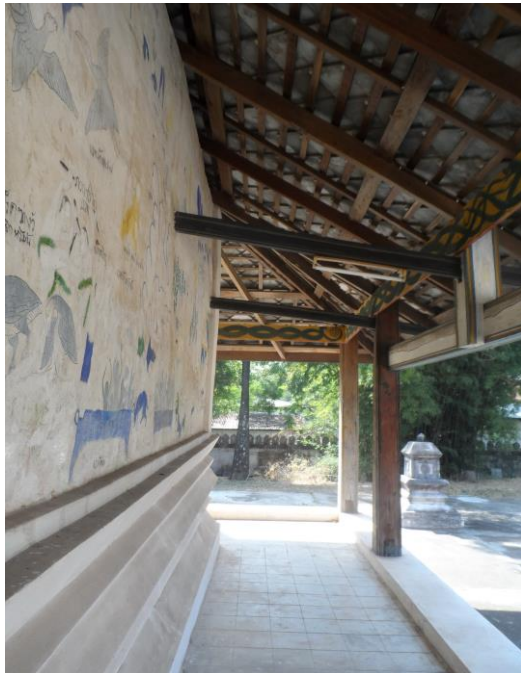
ภาพที่ 5.4 โครงสร้างเสาและโครงหลังคาของระเบียงรอบอุโบสถวัดบรมคณา
