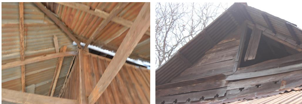
ภาพที่ 4.6 โครงสร้างใต้หลังคา และหน้าบันของอุโบสถวัดสระแก
