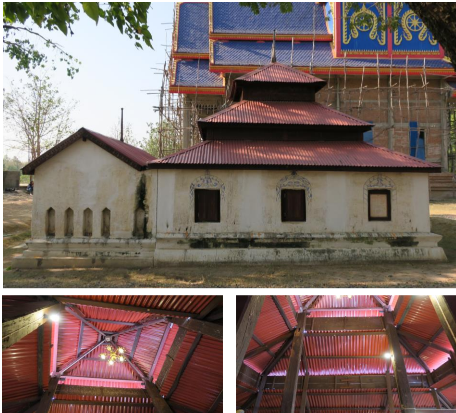
ภาพที่ 3.8 โครงสร้างหลังคาของอุโบสถวัดหลักศิลา
