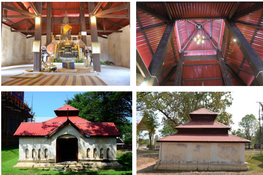
ภาพที่ 3.5 โครงสร้างเสาและโครงหลังคาของอุโบสถวัดหลักศิลา
