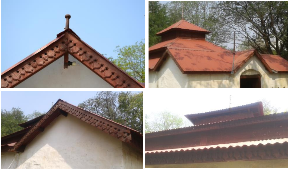
ภาพที่ 3.13 เเชิงชายไม้แกะสลัก และส่วนประดับสันหลังคาของอุโบสถวัดหลักศิลา
