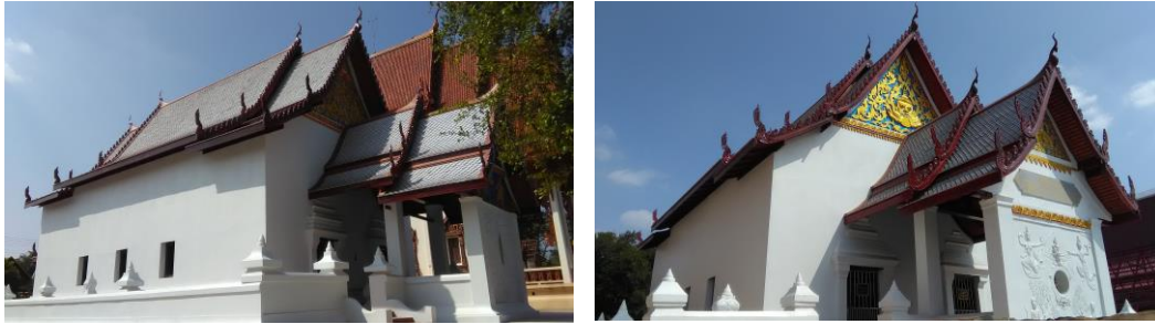
ภาพที่ 10.4 อุโบสถวัดกลางนางรอง หลังการบูรณะ ถ่ายเมื่อ 13 กุมภาพันธ์ พ.ศ. 2560
