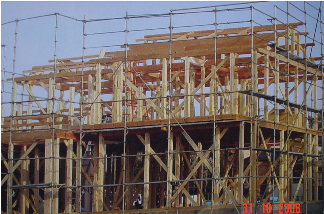
ภาพที่ 6.1 โครงหลังคาไม้ บ้านพักอาศัย ประเทศญี่ปุ่น
