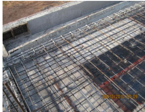
ภาพที่ 5.14 การเสริมเหล็กพื้นคอนกรีตชั้นล่าง และการเสริมเหล็กพื้นคอนกรีตชั้นที่สอง
