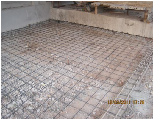
ภาพที่ 5.14 การเสริมเหล็กพื้นคอนกรีตชั้นล่าง และการเสริมเหล็กพื้นคอนกรีตชั้นที่สอง
