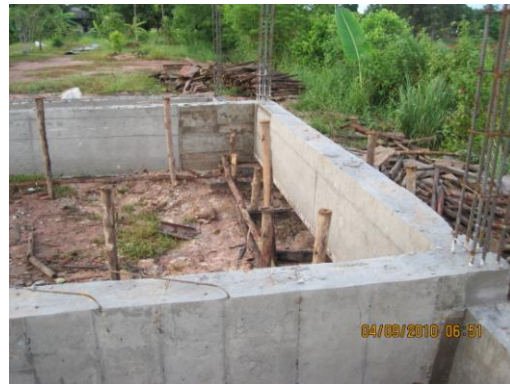
ภาพที่ 4.7 การหล่อคานคอดินที่เป็นพื้นวางบนดิน กับการหล่อคานคอดินที่ใช้พื้นคอนกรีตสำเร็จรูปวางบนคาน
