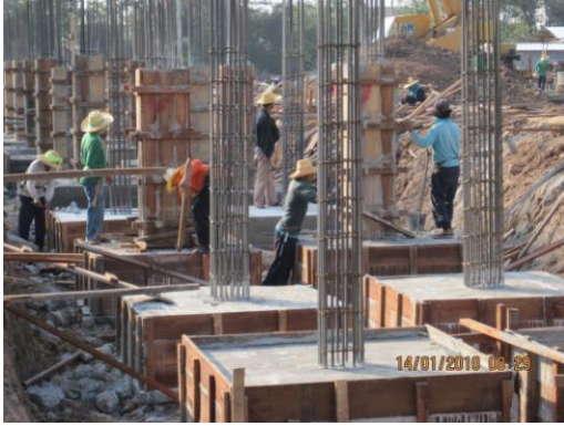
ภาพที่ 4.6 งานหล่อคอนกรีตฐานราก และคอนกรีตเสา
