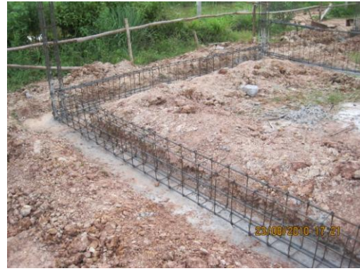
ภาพที่ 4.2 คอนกรีตหยาบเป็นวัสดุรองพื้นสำหรับหล่อคานคอดิน
