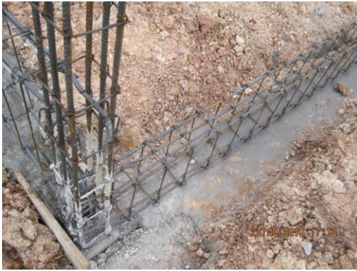
ภาพที่ 4.2 คอนกรีตหยาบเป็นวัสดุรองพื้นสำหรับหล่อคานคอดิน
