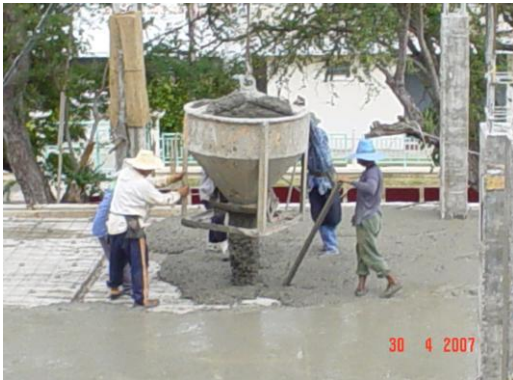
ภาพที่ 4.10 การเทคอนกรีตทับหน้าแผ่นพื้นสำเร็จรูป
