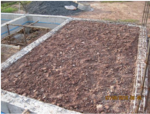
ภาพที่ 4.3 ดินลูกรังและทรายหยาบเป็นวัสดุรองพื้นสำหรับหล่อพื้น
