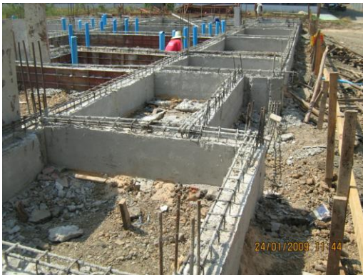
ภาพที่ 4.7 การหล่อคานคอดินที่เป็นพื้นวางบนดิน กับการหล่อคานคอดินที่ใช้พื้นคอนกรีตสำเร็จรูปวางบนคาน
