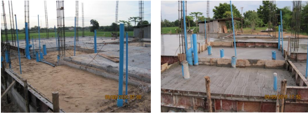
ภาพที่ 4.8 การใช้ทรายรองพื้นก่อนหล่อพื้นคอนกรีตของห้องน้ำโดยมีการฝังท่อพีวีซีไว้ก่อน
