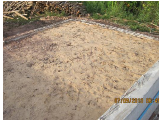
ภาพที่ 4.3 ดินลูกรังและทรายหยาบเป็นวัสดุรองพื้นสำหรับหล่อพื้น
