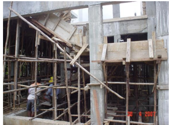
ภาพที่ 3.5 ไม้แบบหล่อ ไม้คร่าวสำหรับยึดแบบและไม้ค้ำยันแบบหล่อบันไดและชานพัก
