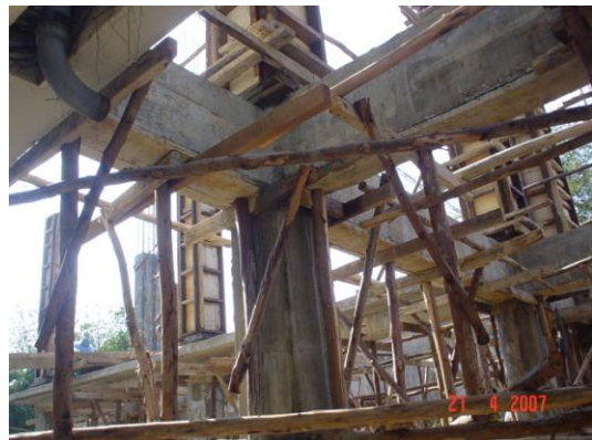
ภาพที่ 3.4 ไม้แบบหล่อคาน และไม้คร่าวสำหรับยึดแบบและไม้ค้ำยันแบบหล่อคาน
