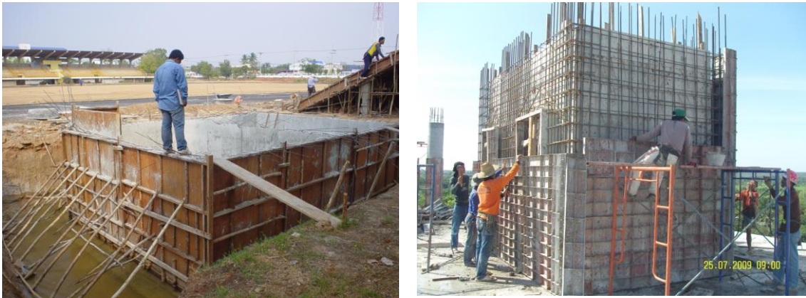
ภาพที่ 3.7 ไม้แบบหล่อถึงเก็บน้ำ และไม้แบบหล่อ ไม้คร่าวสำหรับยึดแบบและไม้ค้ำยันแบบหล่อผนังลิฟต์
