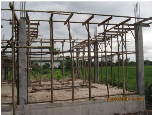
ภาพที่ 3.4 ไม้แบบหล่อคาน และไม้คร่าวสำหรับยึดแบบและไม้ค้ำยันแบบหล่อคาน
