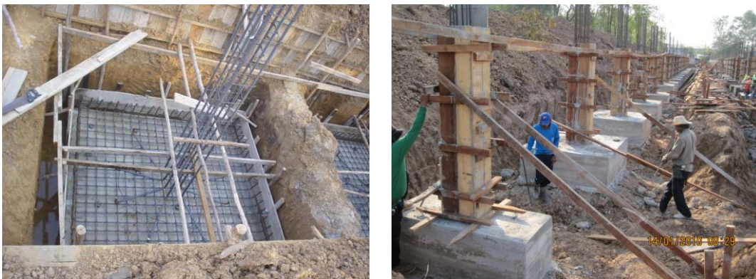
ภาพที่ 3.2 ไม้แบบหล่อฐานราก และไม้แบบหล่อ ไม้คร่าวสำหรับยึดแบบและไม้ค้ำยันแบบหล่อ ต่อม่อ
