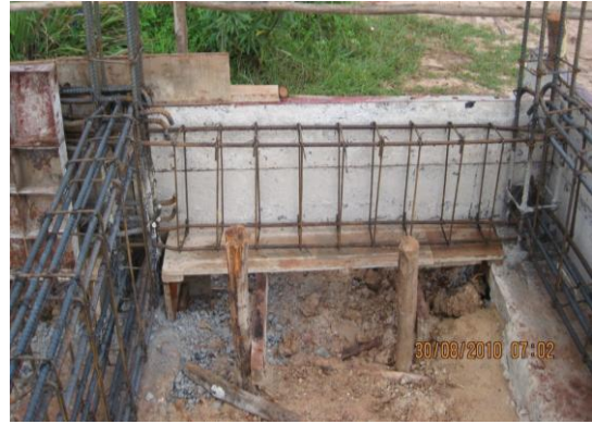
ภาพที่ 3.3 ไม้แบบหล่อคานคอดิน ที่ได้ห้องคานอยู่ระดับเดียวกับดินบริเวณกับไม้แบบหล่อคานคอดินที่ได้ห้องคานสูงกว่าระดับดินบริเวณ
