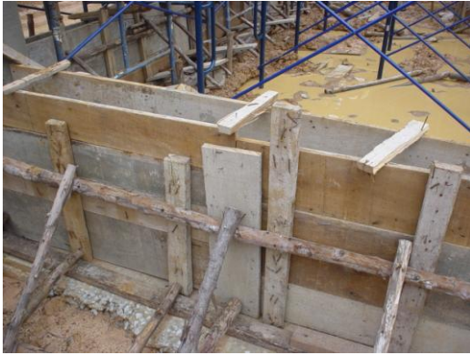
ภาพที่ 3.3 ไม้แบบหล่อคานคอดิน ที่ได้ห้องคานอยู่ระดับเดียวกับดินบริเวณกับไม้แบบหล่อคานคอดินที่ได้ห้องคานสูงกว่าระดับดินบริเวณ
