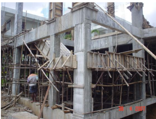
ภาพที่ 3.5 ไม้แบบหล่อ ไม้คร่าวสำหรับยึดแบบและไม้ค้ำยันแบบหล่อบันไดและชานพัก
