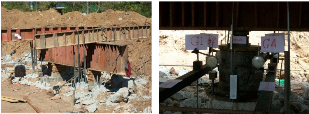
ภาพที่ 2.4 การทดสอบการรับน้ำหนักได้ของเสาเข็มด้วยวิธี pile load test
