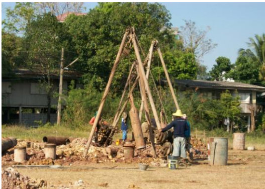
ภาพที่ 2.2 การหล่อเสาค้ำคอนกรีตเสริมเหล็ก
