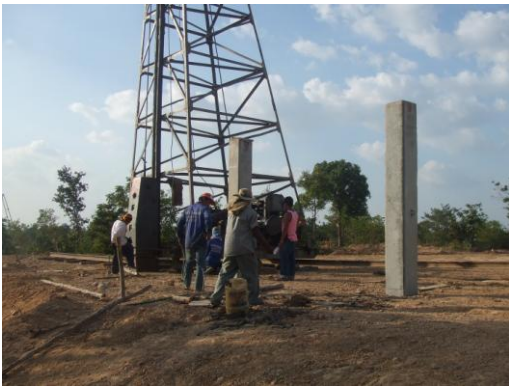
ภาพที่ 2.1 การตอกเสาค้ำ และการสกัดหัวเสาค้ำ
