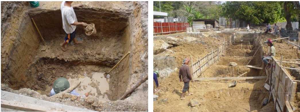
ภาพที่ 2.5 การขุดดินเพื่อก่อสร้างฐานราก
