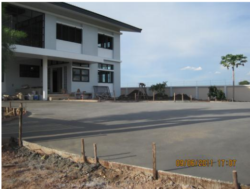
ภาพที่ 12.1 การก่อสร้างถนนและทางเดินเท้า
