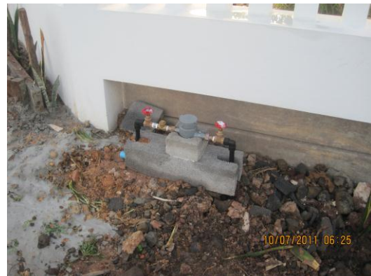
ภาพที่ 12.5 การเดินท่อประปาสาธารณะและติดตั้งมาตรวัดน้ำประปา
