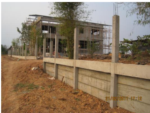
ภาพที่ 12.6 การก่อสร้างโครงสร้างรั้วและผนังรั้ว
