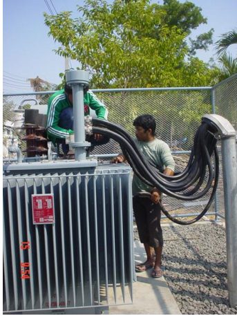
ภาพที่ 12.2 การติดตั้งหม้อแปลงไฟฟ้าและการเดินสายแรงต่ำเข้าอาคาร
