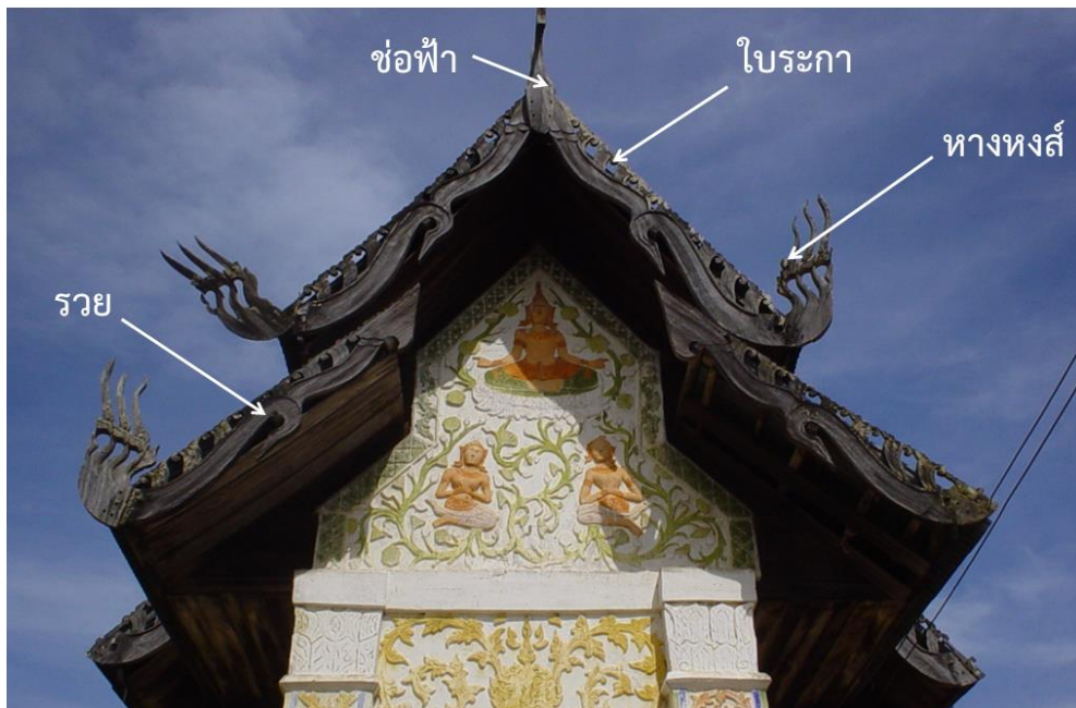
ภาพที่ 6.18 ส่วนประดับหลังคาของอุโบสถวัดหนองบัวเจ้าป่า อำเภอสตึก
