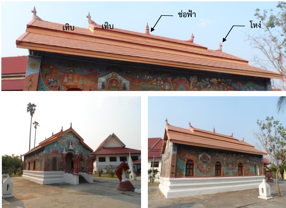
ภาพที่ 6.19 หลังคาทรงจั่วมีเทิบซ้อน อุโบสถวัดมณีจันทร์ อำเภอยะโฮง มุงด้วยแผ่นกระเบื้องไฟเบอร์ซีเมนต์ที่มีรูปร่างแผ่นคล้ายกระเบื้องว่าว
