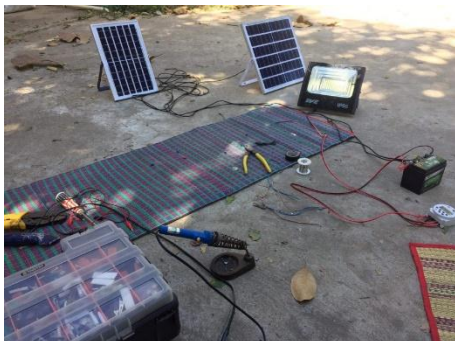
ภาพที่ 7 ต่อสายไฟเข้าด้วยกัน
