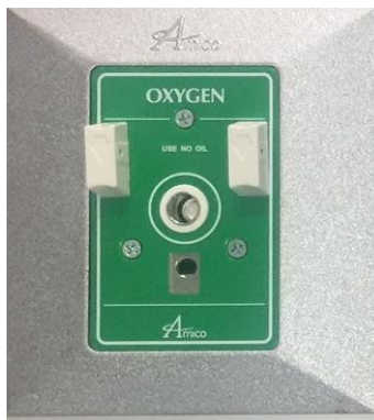
รูปที่ 7.4 ออกซิเจนจาก central supply ที่ส่งมาตาม pipeline
