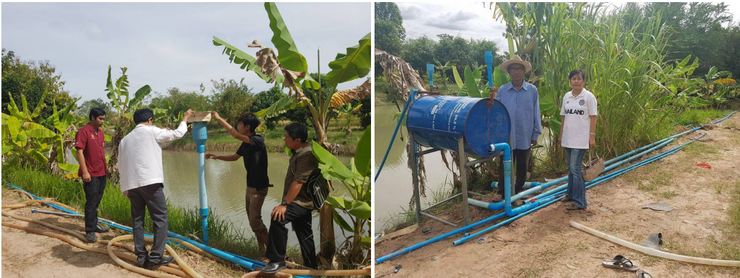
ภาพที่ 2 นวัตกรรมระบบสูบน้ำใช้แรงดันอากาศที่พัฒนาขึ้นใหม่
